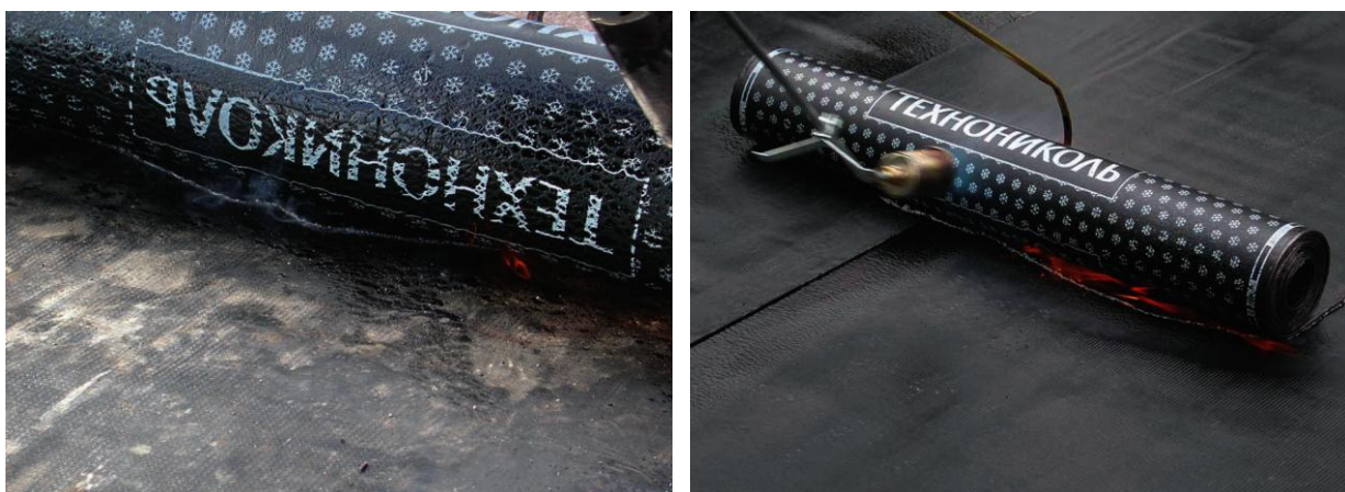
Рис. 7. Валик расплавленного битумно-полимерного вяжущего
