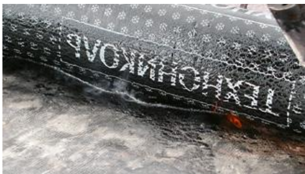
Рис. 10.5. Валик расплавленного битумно-полимерного вяжущего
