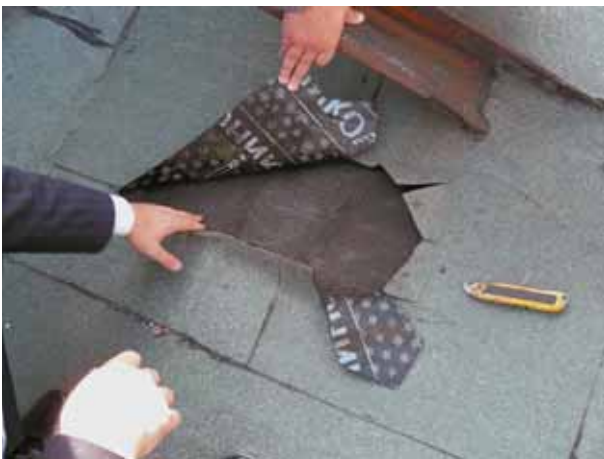
Фото 23 Отсутствие деформации индикаторного рисунка
