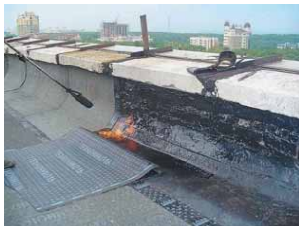
Фото 38 Прогрев основания под кровельный ковер
