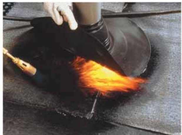
Фото 48 Вплавление юбки переходника в кровельный ковер
