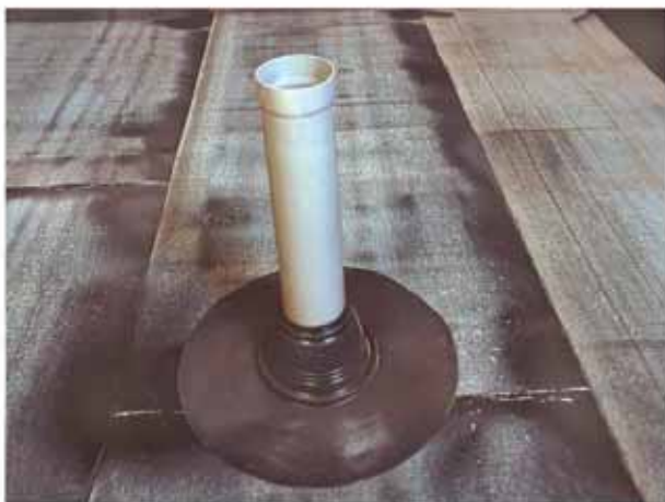
Фото 47 Установка переходника на трубу
