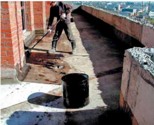
Фото 7 Огрунтовка основания праймером
