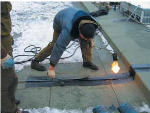
Фото 12 Подготовка к наплавлению на материал с посыпкой
