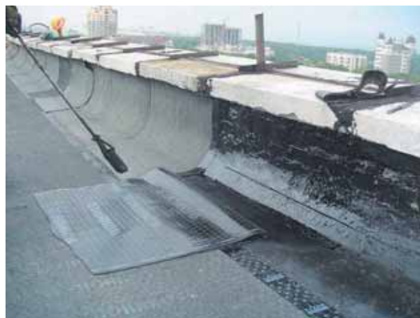
Фото 39 Разогрев кровельного ковра после прогрева основания
