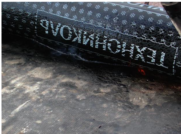
Рис. 5.2 Валик расплавленного битумно-полимерного вяжущего
