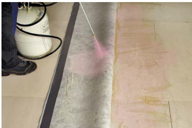
Рис. 5.17 Укладка мембрана при двухстороннем нанесении клеевого состава
