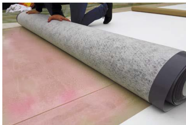
Рис. 5.16 Укладка мембрана при одностороннем нанесении клеевого состава
