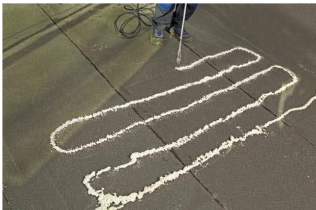
Рис. 5.4 Нанесение клеевого состава LOGICROOF SPRAY Клей Пена
