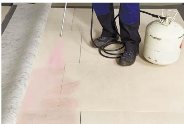
Рис. 5.15 Нанесение клеевого состава LOGICROOF Spray Клей контактный
