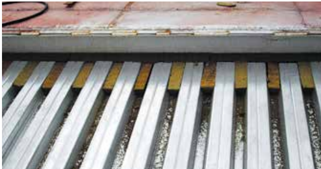
Рис. 7.1. Заполнение пустот ребер профнастила минераловатым утеплителем в местах примыкания.
