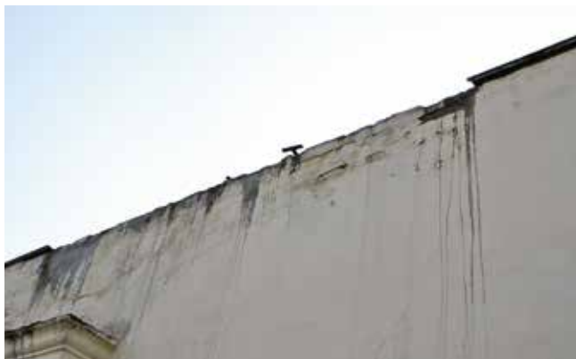
Рис. 4.17. Отсутствие картин карнизного свеса
