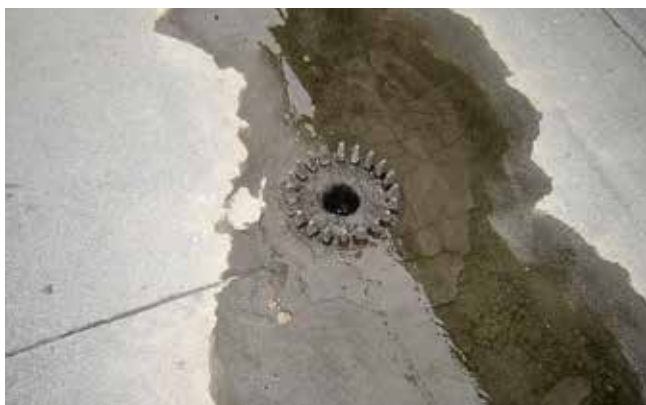
Рис. 4.15. Образование застойных зон
