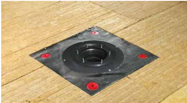
Рис. 7.45. Механическая фиксация слоя усиления водоприёмной воронки
