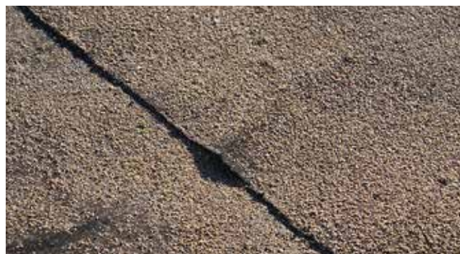
Рис. 4.5. Расслоение полотнищ материала
