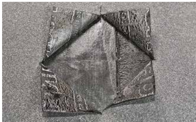
Рис. 8.2 Устранение вздутия водоизоляционного ковра
