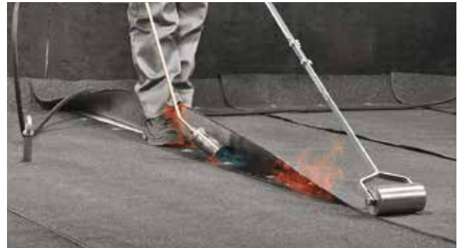
Рис. 7.47. Сварка шва с использованием газовой горелки
