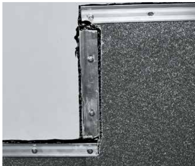
Рис. 7.23. Обрамление края кровельного ковра краевой рейкой
