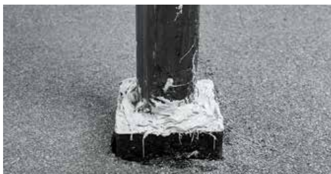
Рис. 7.37. Примыкание кровли к трубам малого диаметра
