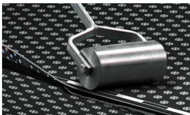
Рис. Д.2. 1 — Сварка бокового шва; 2 — Прикатка бокового шва
