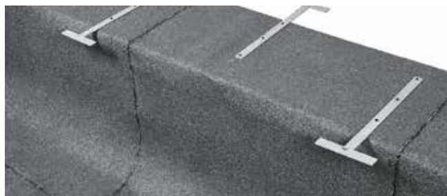
Рис. 7.28. Установка кровельных костылей
