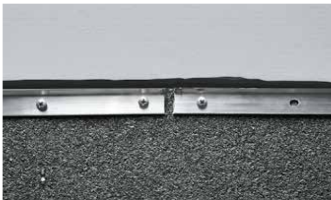
Рис. 7.21. Зазор между краевыми рейками
