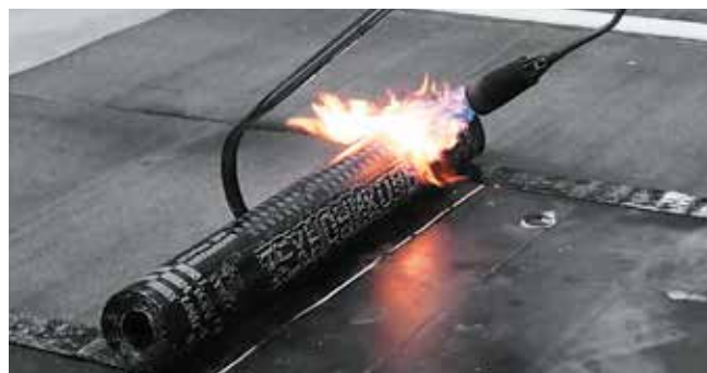
Рис. Д.1. Наплавление по теплоизоляционным плитам
