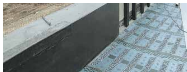
Рис. 7.15. Обшивка листами АЦЛ (ЦСП) вертикальной поверхности
