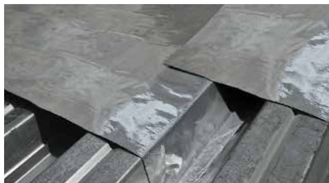
Рис. 7.6. Формирование продольного нахлеста пароизоляции на профлисте
