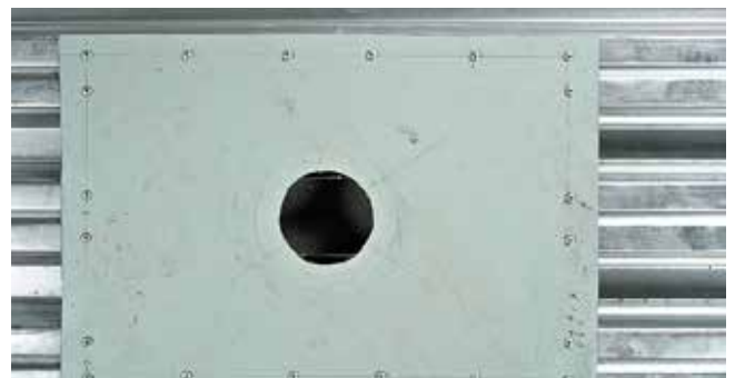
Рис. 7.4 Лист усиления в месте прохода через профилированный лист водоприемной воронки
