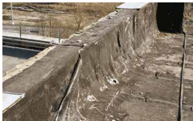
Рис. 4.13. Отсутствие элементов из оцинкованной стали
