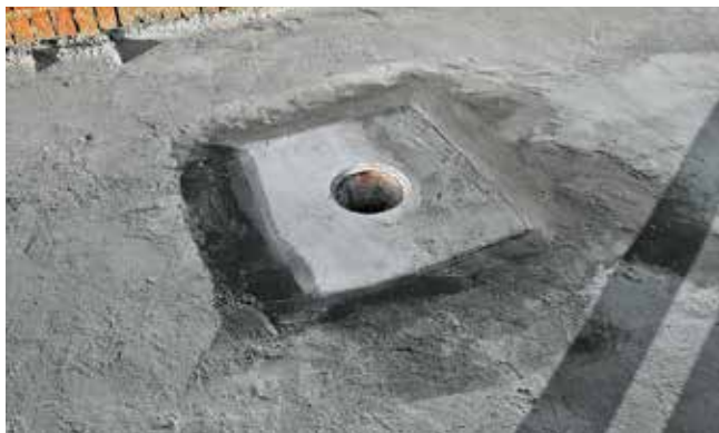
Рис. 7.12. Локальное понижение в месте установки воронки
