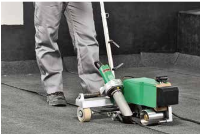
Рис. 7.46. Сварка шва автоматическим оборудованием
