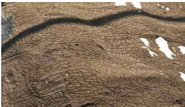
Рис. 4.8. Растрескивание кровли
