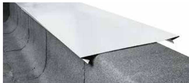
Рис. 7.29. Установка парапетной крыши
