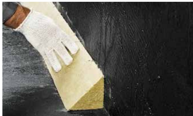
Рис. 7.13. Устройство наклонного бортика
