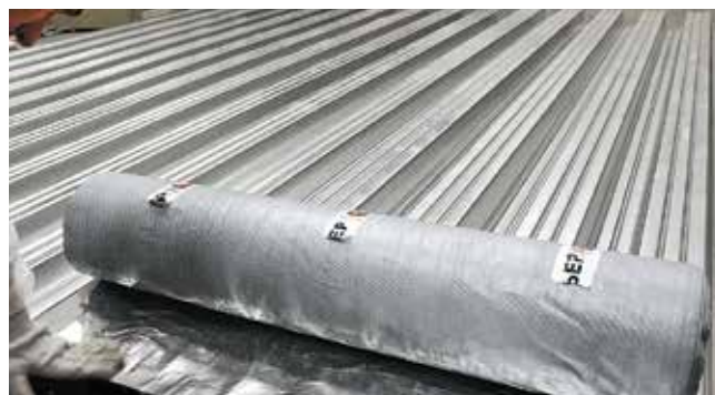
Рис. 7.5. Укладка пароизоляционного материала по профлисту
