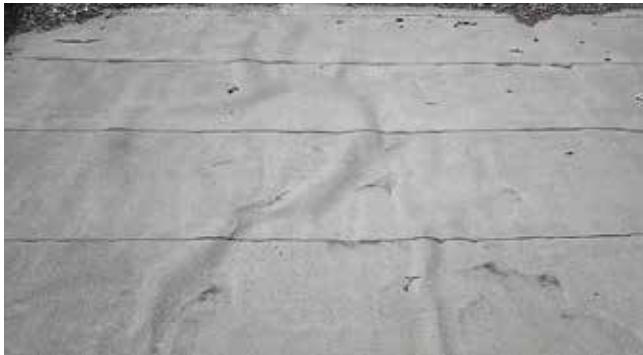
Рис. 4.7. Вздутия кровли
