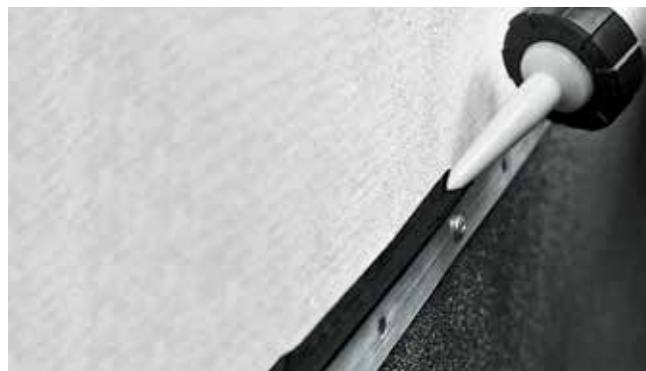
Рис. 7.24. Герметизация края краевой рейки
