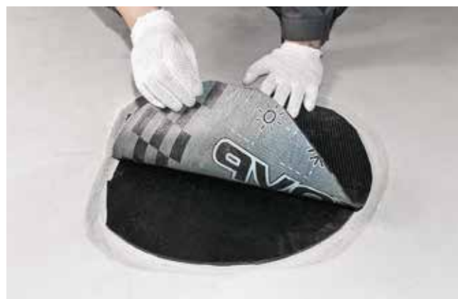
Рис. 9.1 Установка заплаты
