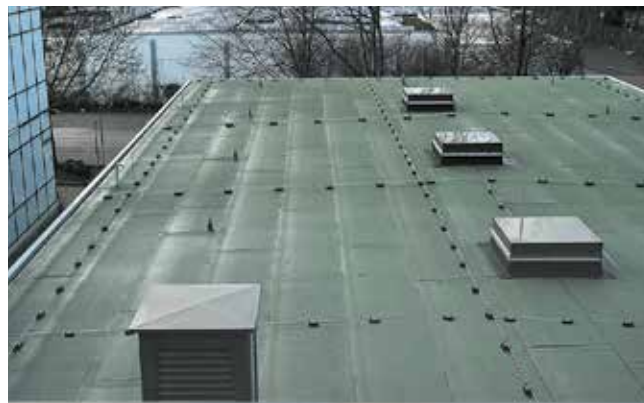
Рис. 7.51. Устройство молниеприемной сетки на кровле
