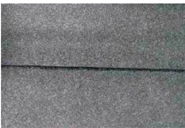
Рис. 5.38. Вытекание битумной массы из-под боковой кромки материала
