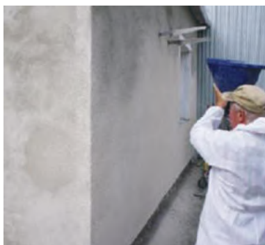
Рис. 2.40. Устройство декоративно-защитного слоя
