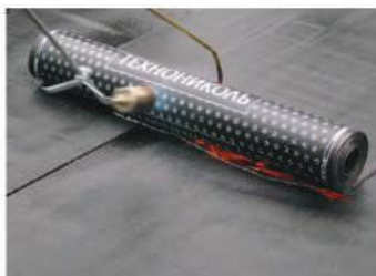
Рис. 1.66. Направление раскатки рулона при огневом приклеивании рулонного материала
