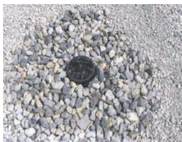
Рис. 1.90. Увеличение фракции балласта вокруг воронки
