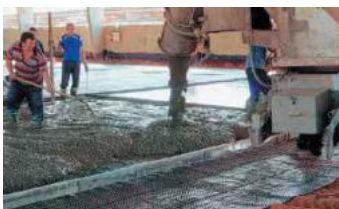
Рис. 5.96. Бетонирование фундаментной плиты
