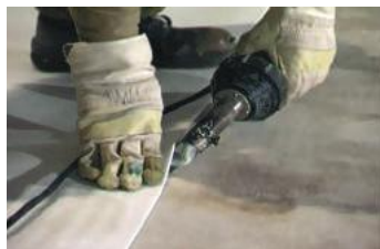
Рис. 5.48. Сварка полотен геотекстиля горячим воздухом
