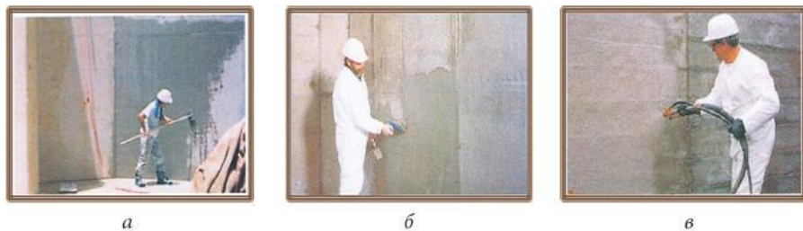
Рис. 5.55. Нанесение цементных обмазочных материалов: а — кистью; б — мастерком; в — распылительным оборудованием
