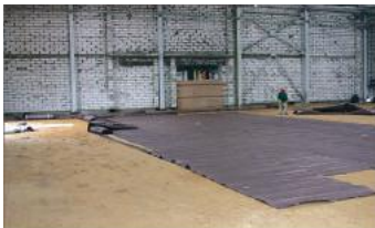
Рис. 5.94. Укладка профилированной мембраны по песчаной подготовке
