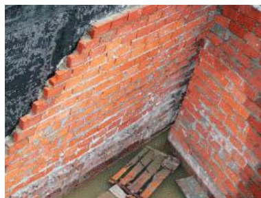
Рис. 5.91. Устройство защитной стенки из кирпича
