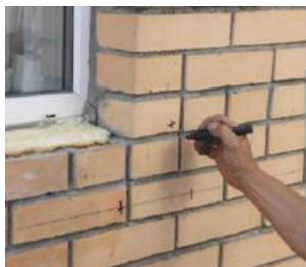
Рис. 2.32. Разметка стены
