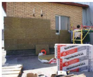
Рис. 2.35. Монтаж теплоизоляционных плит
