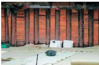
Рис. 5.47. Укладка геотекстиля
