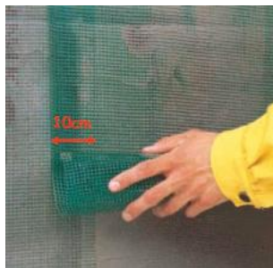
Рис. 2.30. Нанесение армирующей сетки на утеплитель
