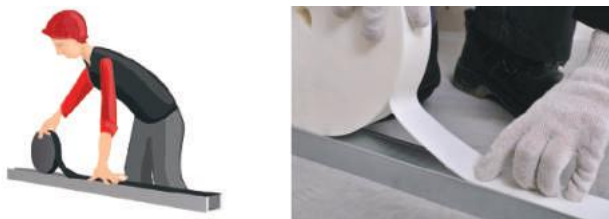
Рис. 3.20. Подготовка направляющего профиля
