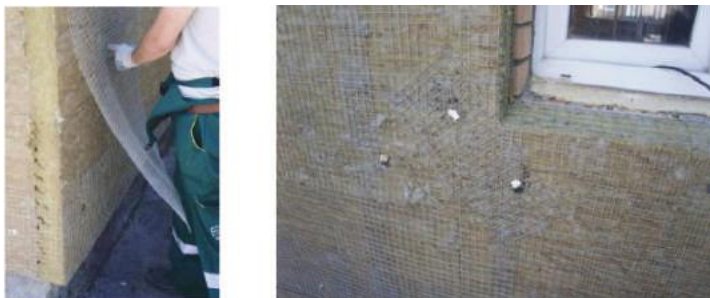
Рис. 2.36. Монтаж сетки
