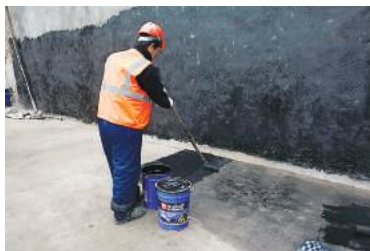
Рис. 5.33. Нанесение праймера на бетонное основание
