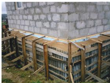
Рис. 5.60. Устройство глиняного замка
