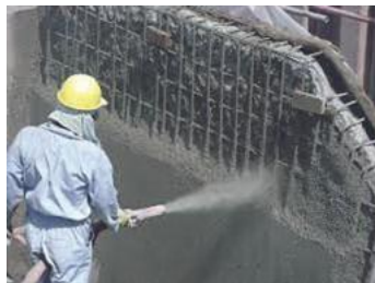
Рис. 5.57. Нанесение гидроизоляционной торкрет-штукатурки на вертикальную поверхность
