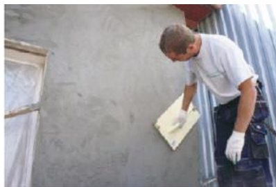
Рис. 2.39. Устройство выравнивающего слоя
