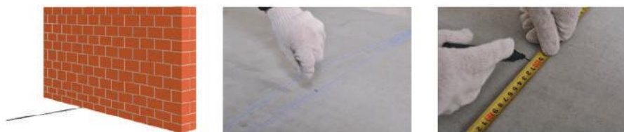
Рис. 3.19. Разметка стен и потолка
