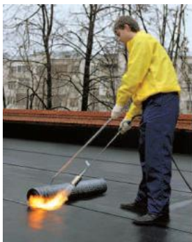
Рис. 1.66. Направление раскатки рулона при огневом приклеивании рулонного материала
