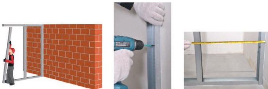
Рис. 3.21 . Установка стоечного профиля
