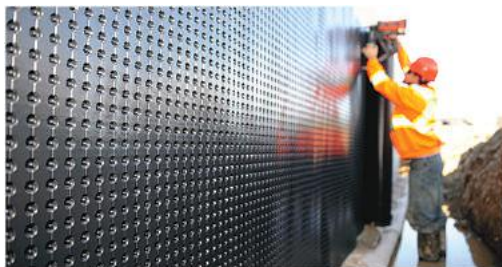
Рис. 5.83. Крепление профилированной мембраны PLANTER standard к основанию
