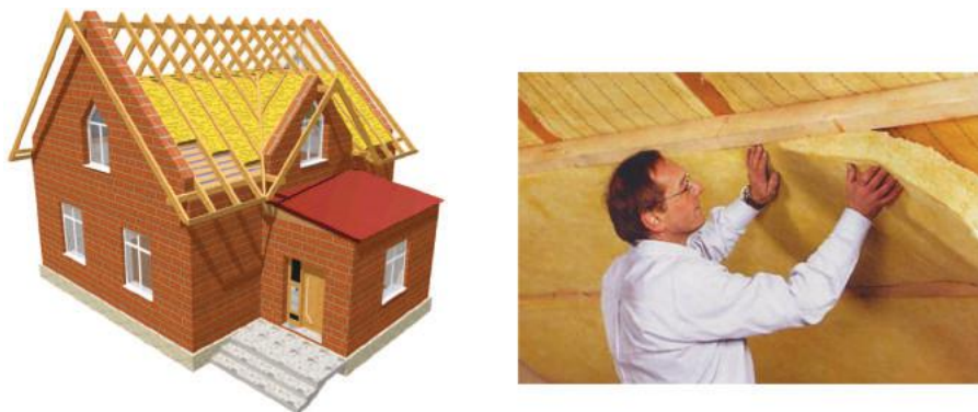
Рис. 1.127. Укладка теплоизоляционных плит из каменной ваты
