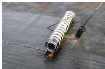
Рис. 1.67. Применение «дышащей» кровли при ремонте
