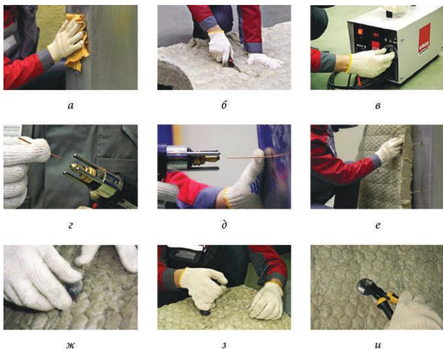
Рис. 4.7. Крепление огнезащитного мата: а — подготовка корпуса воздуховода; б — раскрой огнезащитного материала; в — настройка сварочного оборудования; г — подготовка штифтов и шайб; д — приваривание штифтов; е — навешивание матов; ж — фиксация шайб; з — сшивание матов; и — обрезка шпилек
