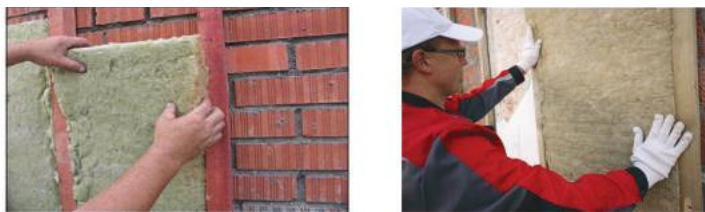
Рис. 2.52. Укладка утеплителя
