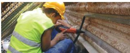
Рис. 5.14. Монтаж набухающего шнура механическим способом
