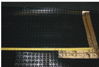
Рис. 5.97. Стыковка рулонов профилированной мембраны
