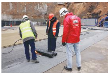
Рис. 5.34. Укладка наплавляемых битумно-полимерных рулонных материалов
