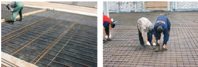
Рис. 5.95. Вязка арматурного каркаса по профилированной мембране
