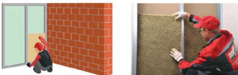
Рис. 3.23. Укладка звукоизоляционных минераловатных плит ТЕХНОАКУСТИК
