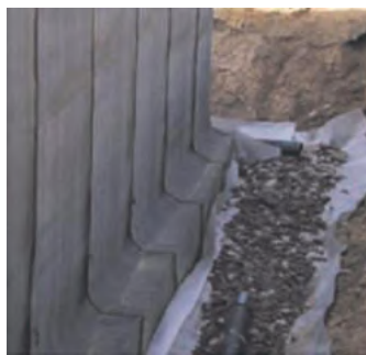
Рис. 5.41. Гидроизоляция вертикальной поверхности
