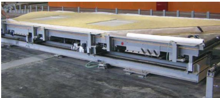
Рис. 2.66. Укладка утеплителя в панель
