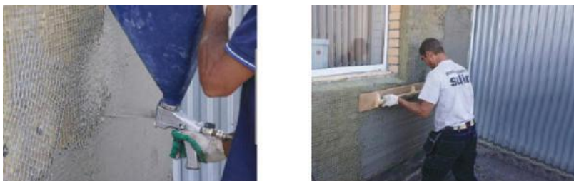
Рис. 2.38. Устройство грунтующего слоя
