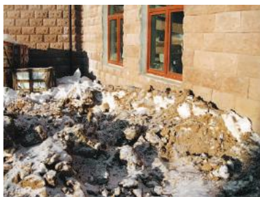
Рис. 5.90. Обратная засыпка котлована смерзшимся грунтом
