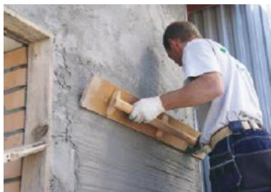
Рис. 2.39. Устройство выравнивающего слоя
