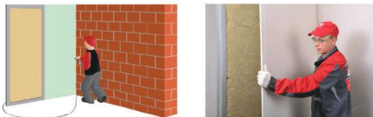
Рис. 3.24. Обшивка второй стороны листом ГКЛ
