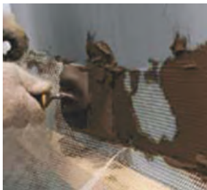
Рис. 2.21. Вдавливание полосы армирующей стеклосетки в клеевую массу
