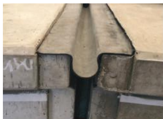
Рис. 5.27. Герметизация деформационного шва битумно-полимерным рулонным материалом Техноэласт ФЛЕКС : а — в деформационном шве с компенсаторной петлей; б — в системе деформационного шва совместно с гидроизоляционным покрытием из битумно-полимерного рулонного материала
