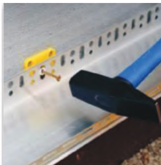
Рис. 2.19. Крепление цокольных планок
