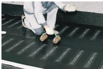
Рис. 5.40. Прикатка нахлестов рулонных материалов
