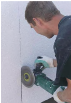
Рис. 2.41. Устройство деформационных швов
