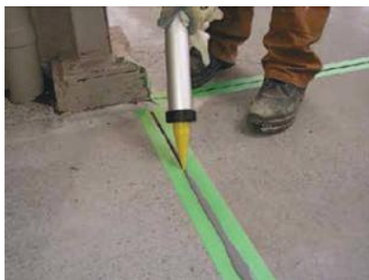
Рис. 5.25. Заполнение полиуретановым герметиком деформационного шва
