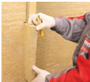
Рис. 2.28. Заполнение щелей полосами из утеплителя
