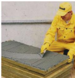
Рис. 2.22. Нанесение клеевого состава на минераловатную плиту зубчатым шпателем
