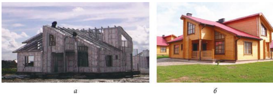
Рис. 2.65. Каркасное здание: a — заполнение каркаса утеплителем; б — готовый коттедж
