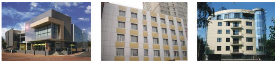
Рис. 2.7. Отделка фасадов плитками из керамогранита производства завода «Уральский гранит»
