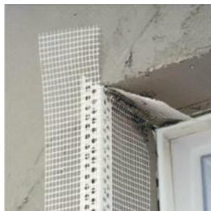
Рис. 2.29. Армирование углов
