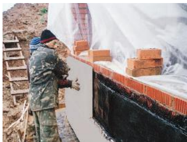
Рис. 5.67. Монтаж теплоизоляционных плит из экструзионного пенополистирола
