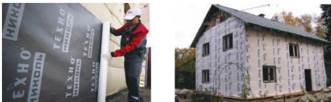
Рис. 2.53. Защита утеплителя диффузионной мембраной
