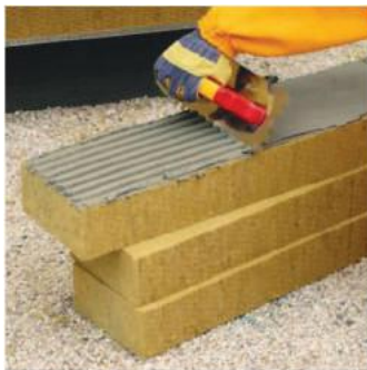
Рис. 2.22. Нанесение клеевого состава на минераловатную плиту зубчатым шпателем
