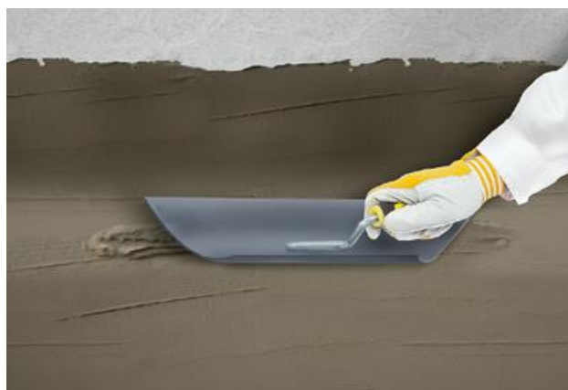
Рис. 3.1. Устройство галтели
