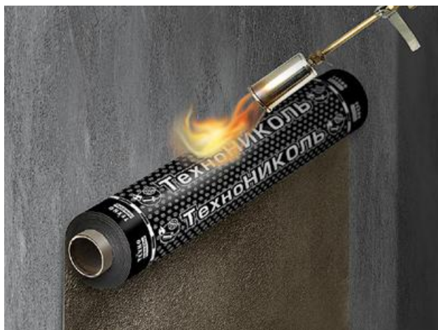
Рис. 4.11. Укладка Техноэласт ТЕРРА на вертикальную поверхность
