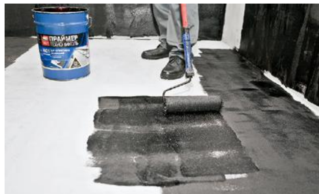
Рис. 3.3. Нанесение праймера валиком
