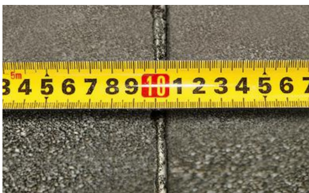
Рис. 4.6. Вытек битумной массы из-под кромки материала
