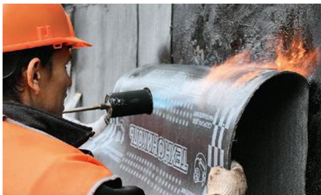
Рис. 2.2. Метод сплошного наплавления
