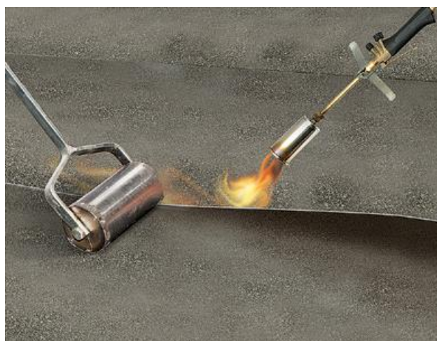
Рис. 5.1. Сварка рулонов в зоне нахлеста
