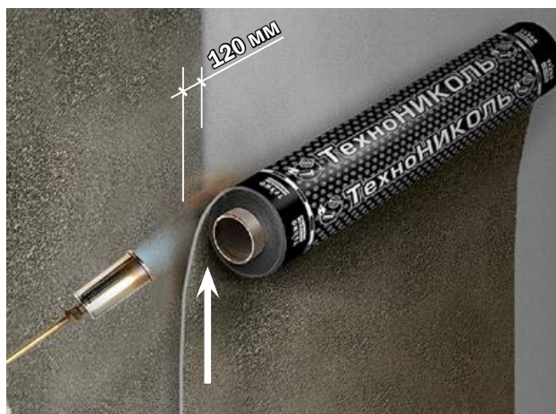
Рис. 5.8. Сварка нахлестов с последующей механической фиксацией рулона
