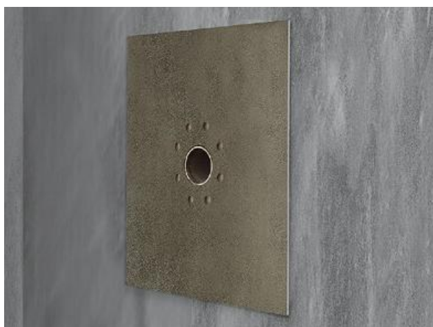
Рис. 4.9. Устройство слоя усиления трубной проходки
