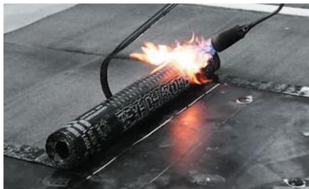
Рис. К.1. Наплавление по теплоизоляционным плитам
