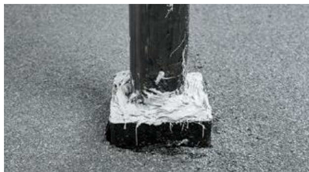
Рис. 3.37. Примыкание кровли к трубам малого диаметра
