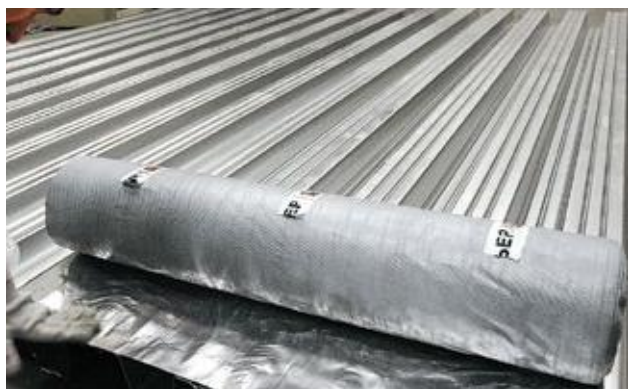
Рис. 3.5. Укладка пароизоляционного материала по профлисту
