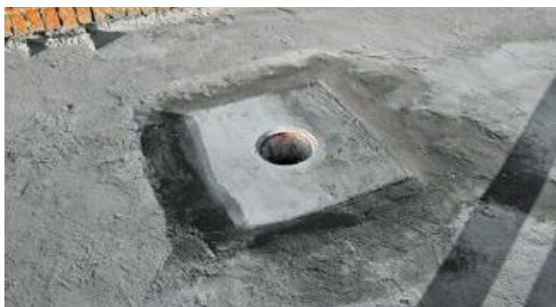
Рис. 3.12. Локальное понижение в месте установки воронки
