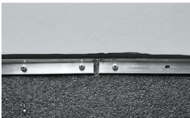
Рис. 3.21. Зазор между краевыми рейками
