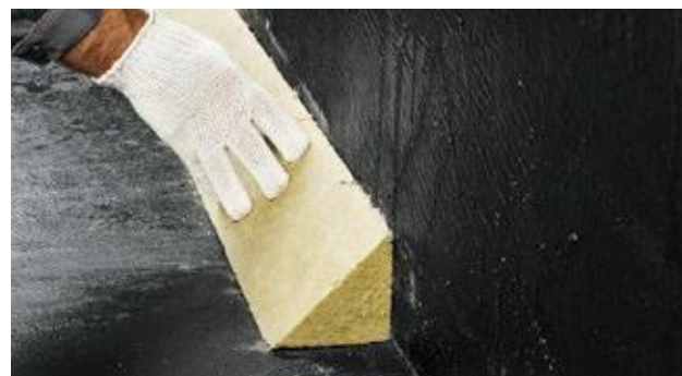
Рис. 3.13. Устройство наклонного бортика
