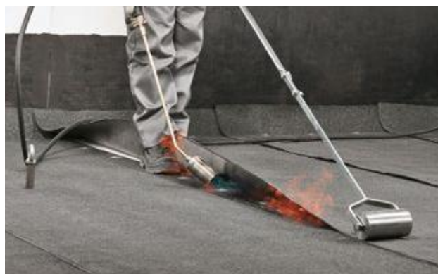
Рис. 3.46. Сварка шва с использованием газовой горелки
