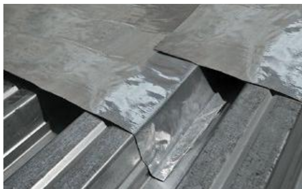
Рис. 3.6. Формирование продольного нахлеста пароизоляции на профлисте
