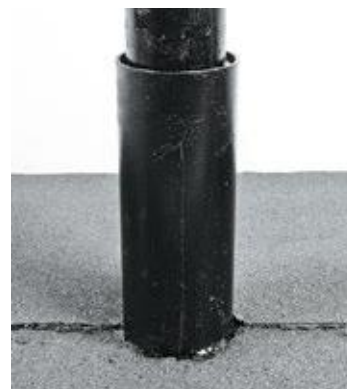
Рис. 3.33. Примыкание кровли к трубе
