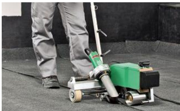
Рис. 3.45. Сварка шва автоматическим оборудованием
