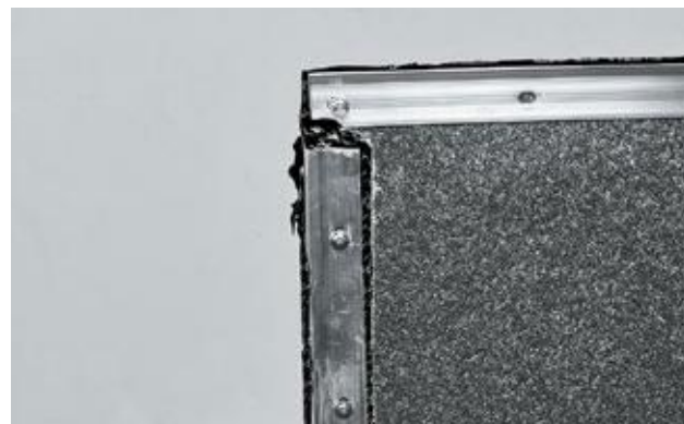
Рис. 3.23. Обрамление края кровельного ковра краевой рейки
