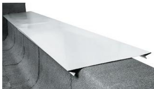
Рис. 3.29. Установка парапетной крышки
