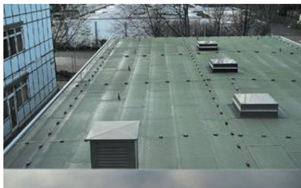
Рис. 3.55. Устройство молниеприемной сетки на кровле
