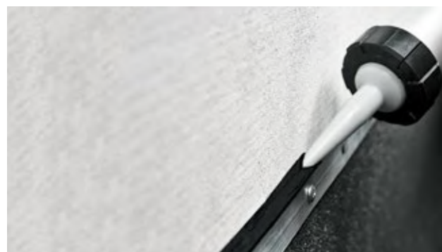
Рис. 3.24. Герметизация края краевой рейки
