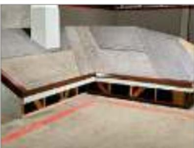
— По остальной площади кровли укладывается один из механически закрепляемых подкладочных материалов: ANDEREP PROF, ANDEREP GL.
