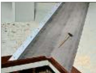
— Дополнительно подкладочный ковер закрепляется кровельными гвоздями с широкой шляпкой.
