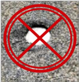
**!** **Важно!** Шляпка гвоздя не должна пробивать ковер – она должна плотно прижимать его к основанию. Перед непосредственным креплением подкладочного ковра гвоздем необходимо расправить материал, чтобы на поверхности не было складок и неровностей.
